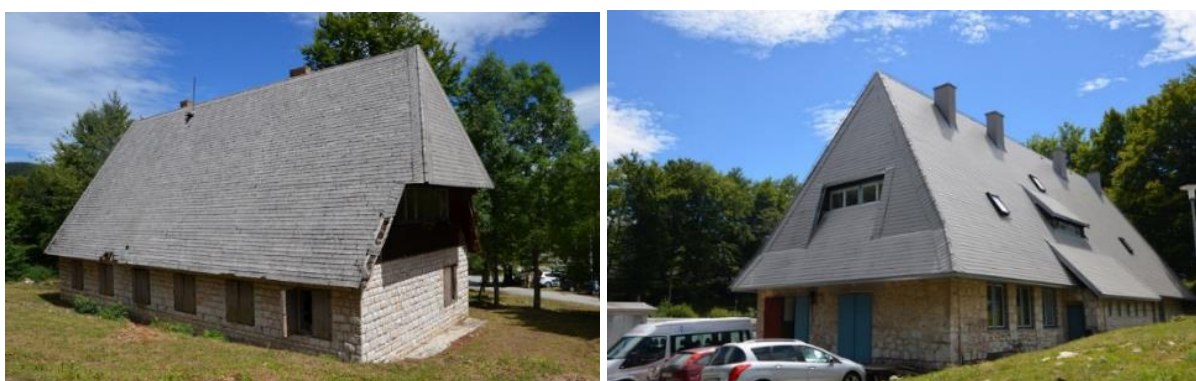
Slika 39. Zgrada nekadašnjeg poštanskog-mjesnog ureda (lijevo) i nekadašnji restoran društvene prehrane (desno) izgrađeni na Mukinjama prema projektu arhitekta Lavoslava Horvata. Arhiva JUNPPJ
