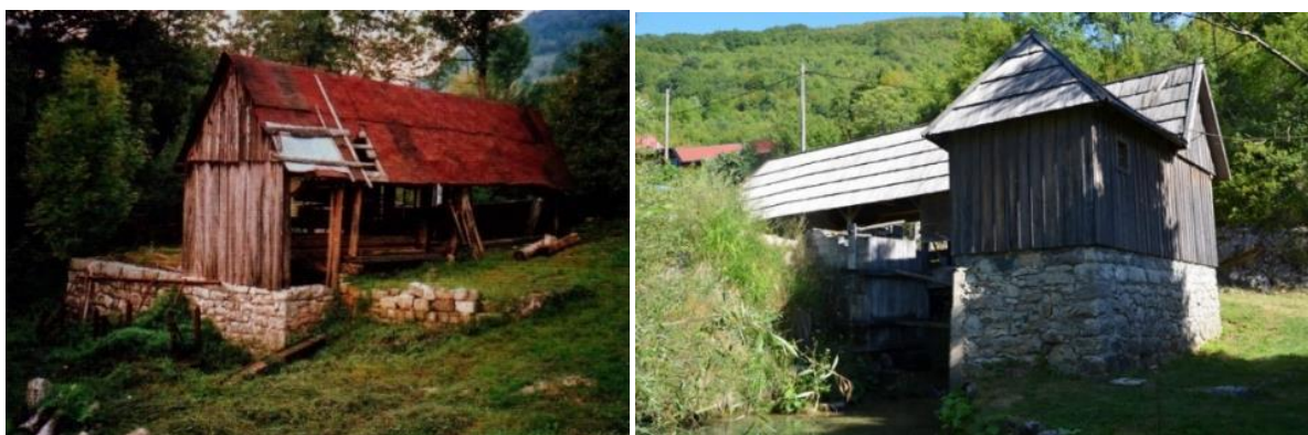
Slika 40. Pilana na vodeni pogon u selu Korana prije obnove (lijevo) i poslije obnove (desno). Arhiva JUNPPJ
