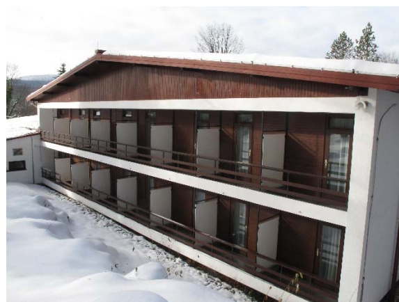
b) Uzdužno pročelje stambenog krila hotela
