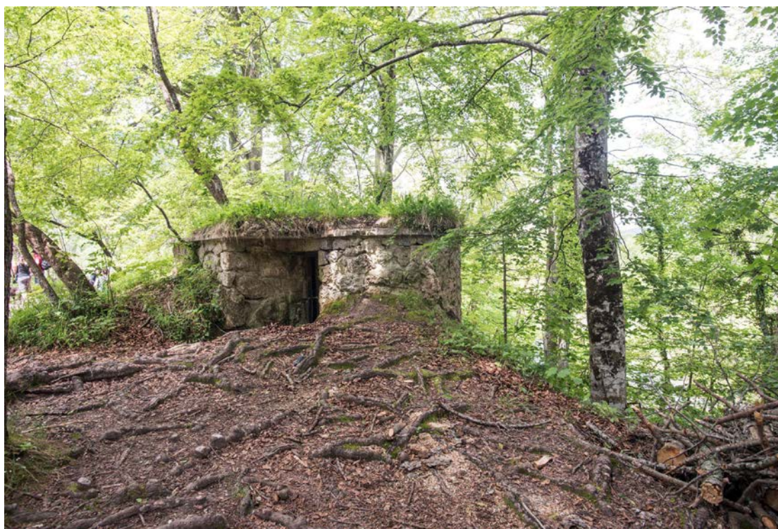
Slika 3. Pogled na gornji dio zgrade strojarnice s jugoistoka
