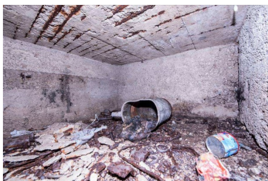
Slika 20. Prostor u koje se pristupa kroz otvor u sjevernom zidu stubišta
