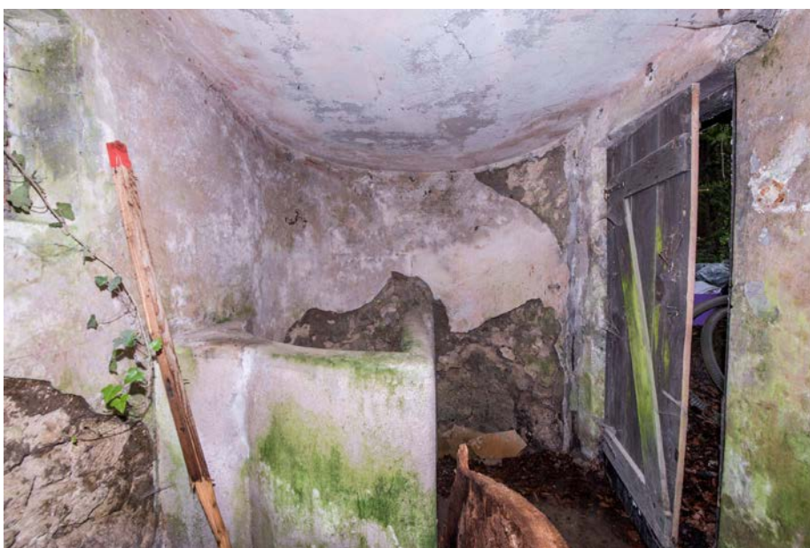
Slika 13. Unutrašnjost gornje prostorije, pogled prema istočnom dijelu
