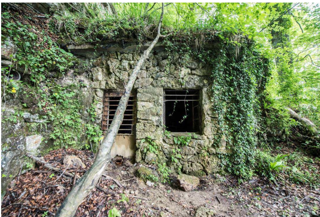
Slika 8. Donji dio zgrade strojarnice hidrocentrale, istočno pročelje
