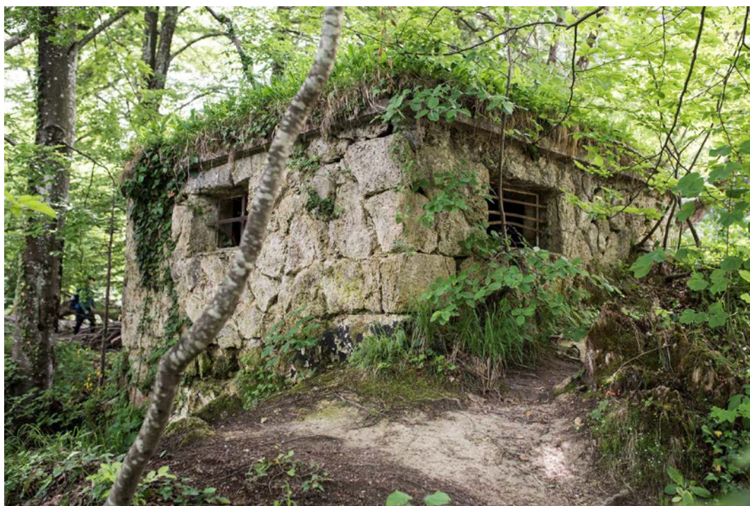
Slika 4. Pogled na gornji dio zgrade strojarnice sa sjeverozapada
