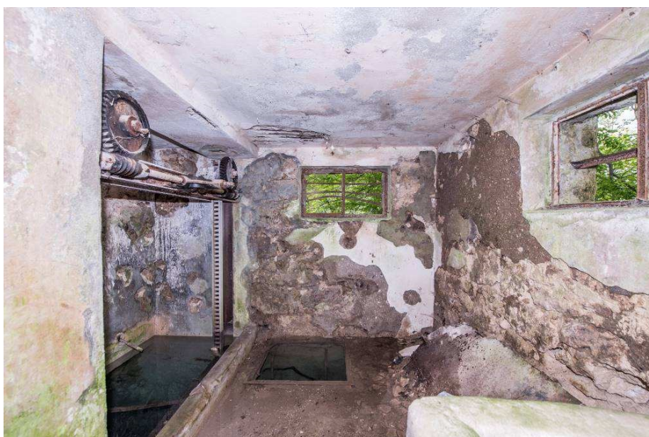
Slika 12. Unutrašnjost gornje prostorije hidrocentrale, pogled prema zapadnom dijelu
