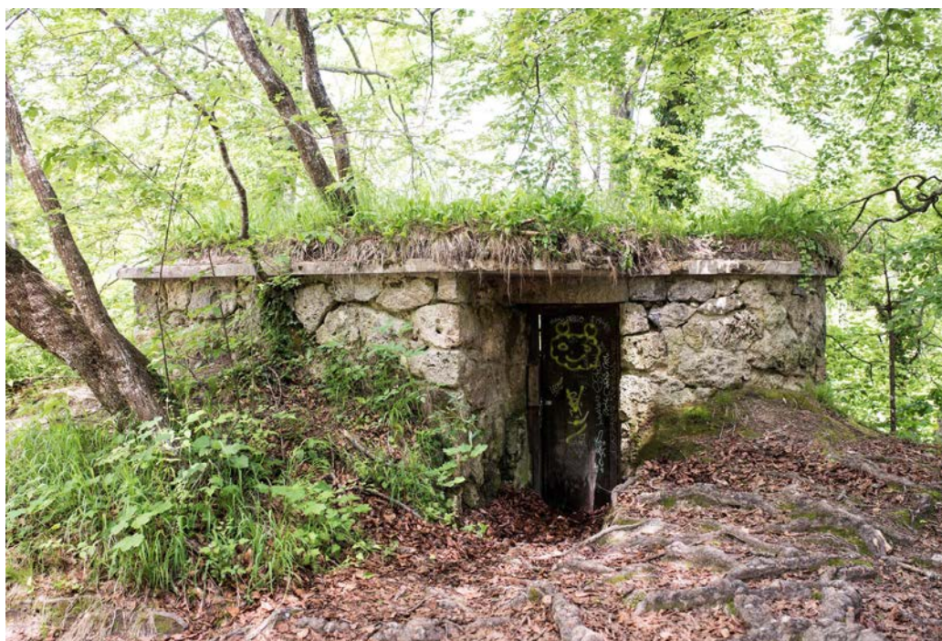
Slika 2. Gornji dio zgrade strojarnice, južno, ulazno pročelje
