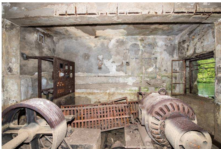
Slika 24. Donja prostorija, pogled prema sjevernom zidu
