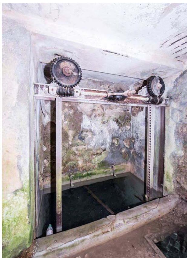
Slika 16. Gornja prostorija, mehanizam ustave u južnom zidu
