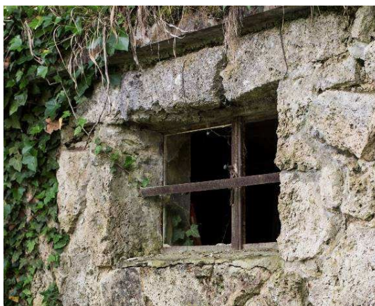
Slika 5. Prozorski otvor na sjevernom pročelju gornjeg dijela zgrade
