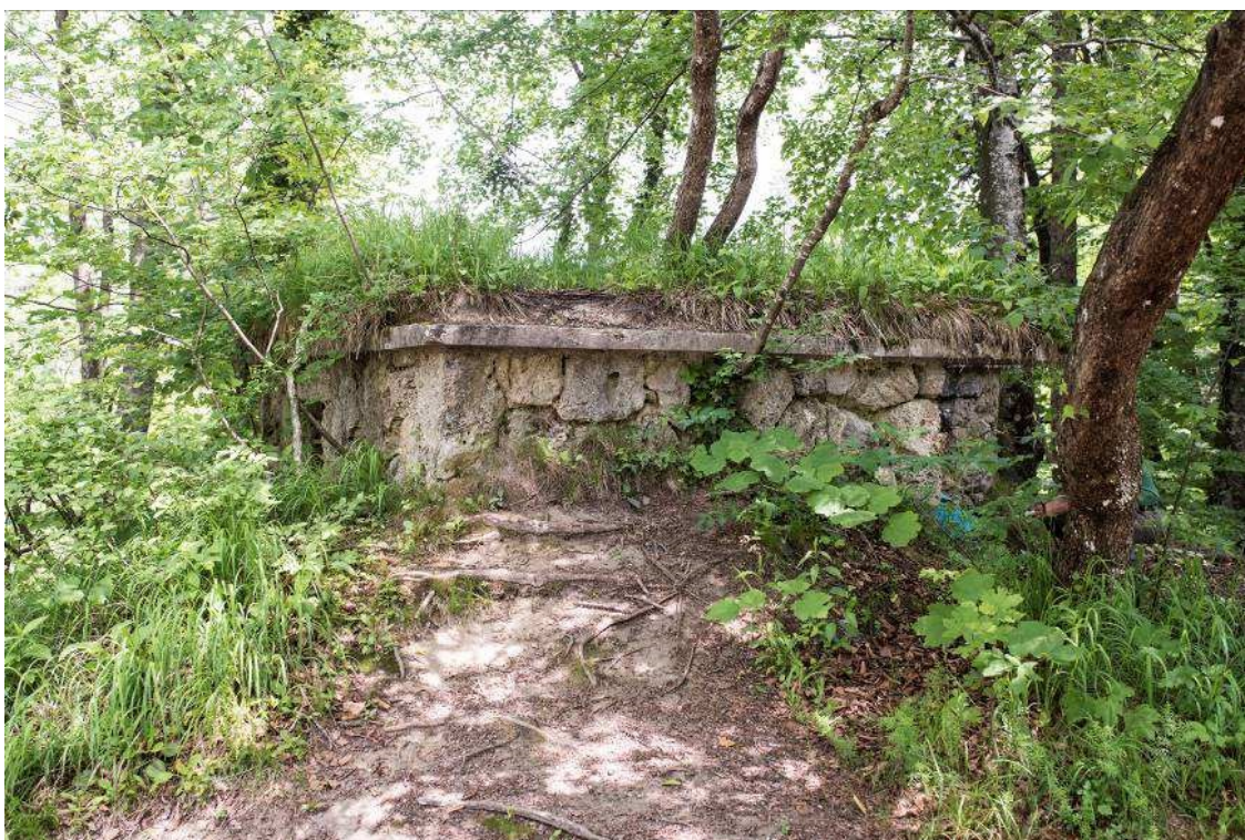
Slika 7. Pogled na hidrocentralu s jugozapada
