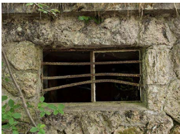
Slika 6. Prozorski otvor na zapadnom pročelju gornjeg dijela zgrade
